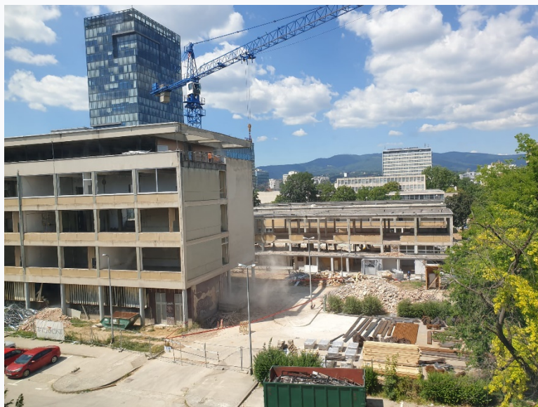
Slika 6.11. Obnova Sjeverne zgrade Fakulteta
