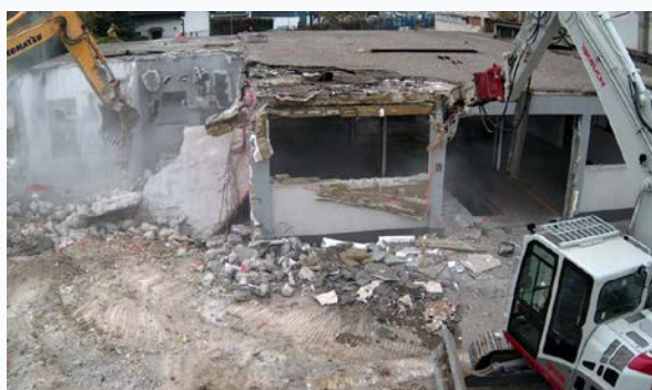
Slika 7.1. Dana 2. studenoga 2022. godine tvrtka Polting d.o.o. započela je radove (rušenje stare zgrade laboratorija).
