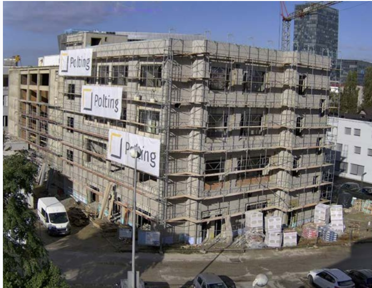
Slika 7.2. Izgradnja nove zgrade laboratorija
